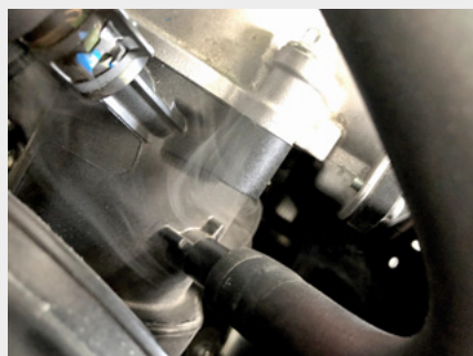
Netěsnost hadice mezi škrticí klapkou a sacím potrubím motoru Mazda 6, 2,5 l benzin, r. v. 2018
